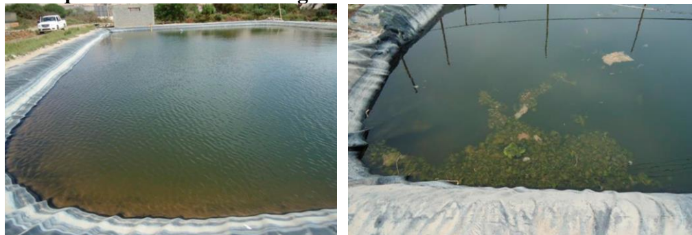
Estanques de acumulación de agua.
